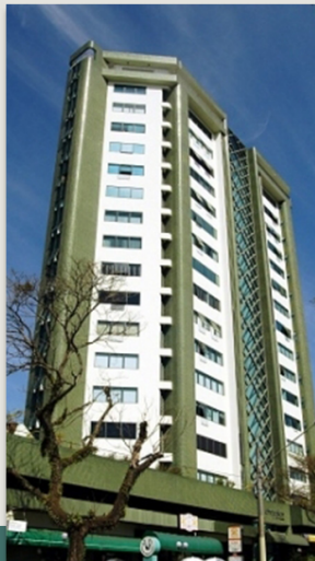
Edifício Metropolitan Offices
